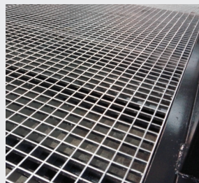
Superficie de la rampe
